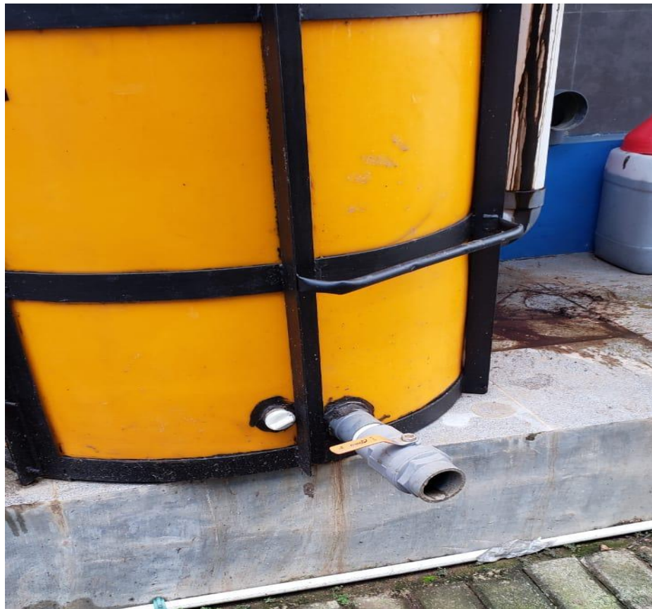
Gambar 9. Pipa pembuangan /pengurasan
